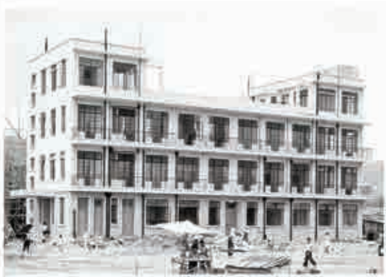
第二代啟明診所施工中（照片由香港教區檔案處提供）
